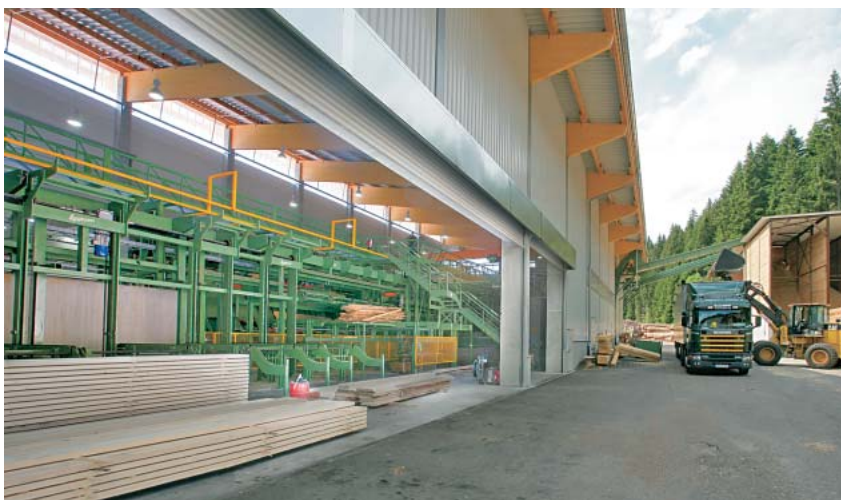
Neu errichtete Sägehalle mit Blick auf die Sortierung sowie Lkw-Verladung (rechts)
